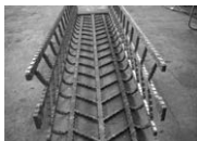
部材に合わせて工場で曲げ加工
