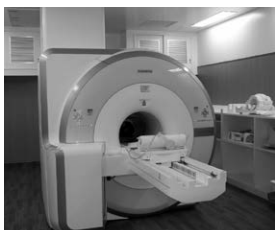
PET-MRI 完成写真 (磁気、電波、放射線シールド施行済み)
