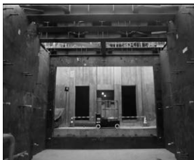
7T-MRI 磁気シールド鉄板工事写真 (EFC材:電磁用軟鉄、約500 ton)
