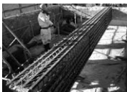
グリッドメタル設置
