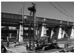
左:小径杭の施工状況 右:低空頭・狭隘地施工
