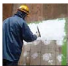
Step 3 中塗剥落防止材
